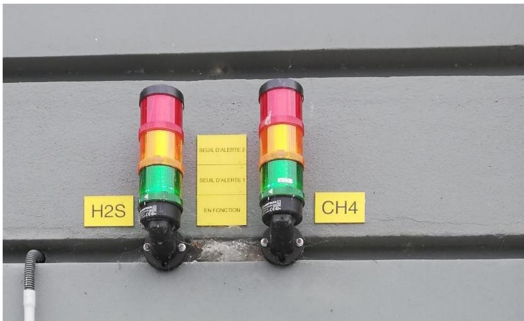
Voyants lumineux des seuils d'alerte (H<sub>2</sub>S et CH<sub>4</sub>) situés à l'extérieur d'une station d'assainissement
