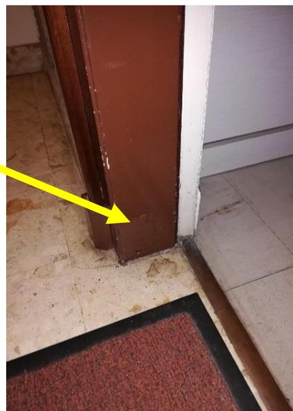
OCI situé sur le palier d'un immeuble, le robinet est ouvert l'indicateur « Z » est dans l'axe de la conduite. En bas la lettre Z permettant d'identifier l'appartement desservi. La même lettre se trouve en bas ou en haut sur le chambranle de la porte palière. © Christophe Perdrisot - DGSCGC
