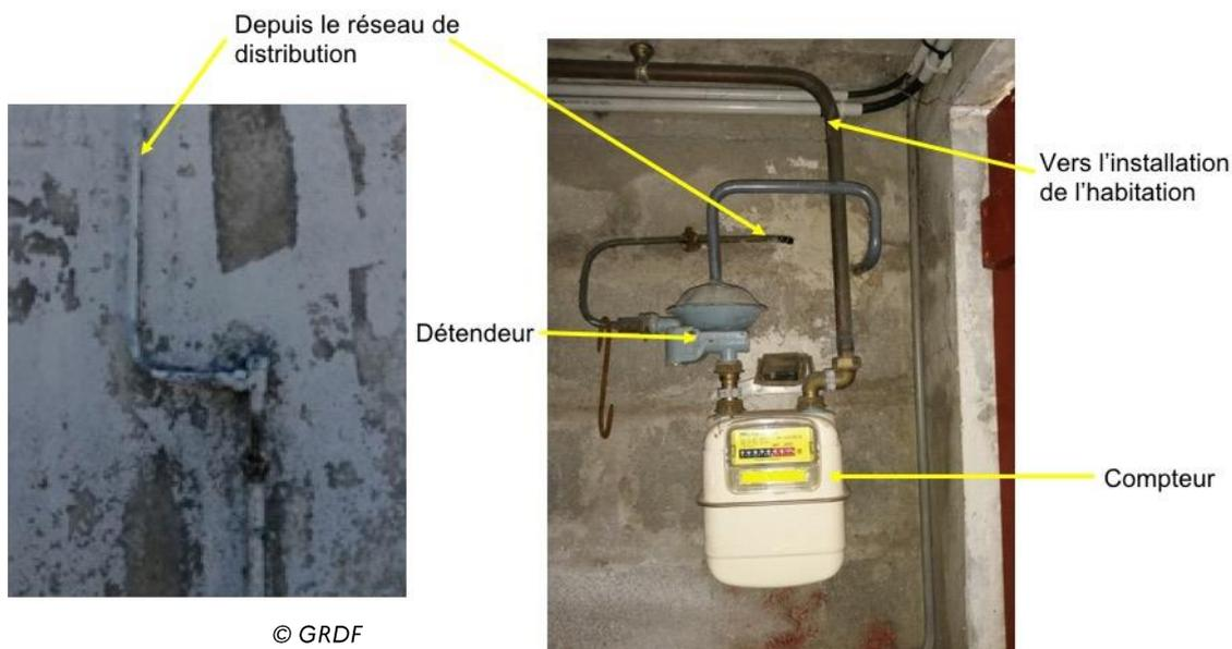
Sur certaines installations, les organes de coupure gaz peuvent prendre la forme de « Té obturateur » ou des « robinets à visser ». Bien que plusieurs modèles soient encore présents sur le territoire français, le principe de fonctionnement de ce type d'organe de coupure reste le même.
