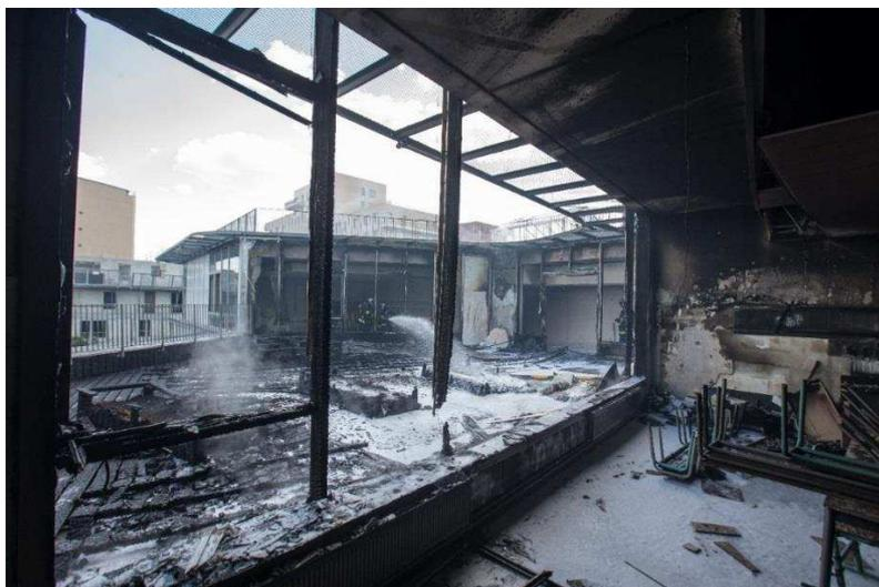
Photo n°1 (@BSPP) : Feux sur un toit-terrasse, avec propagation aux locaux adjacents
