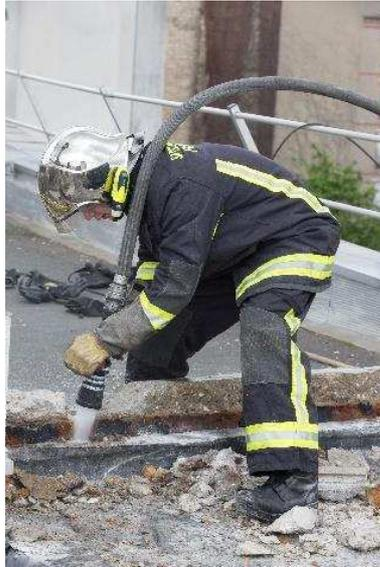
Photo n°3 (@BSPP) : Extinction d'un feu de joint de dilatation entre deux immeubles d'habitation
