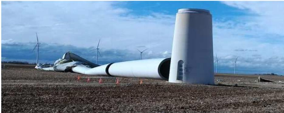
Le COS veillera à réaliser un zonage adapté. Il devra s'assurer de la mise en sécurité électrique de l'éolienne. Ce zonage devra rester matérialisé même après le départ des secours (en cas de vent, notamment vent fort, une distance supérieure sera préférable (à titre indicatif : minimum 6xH).
