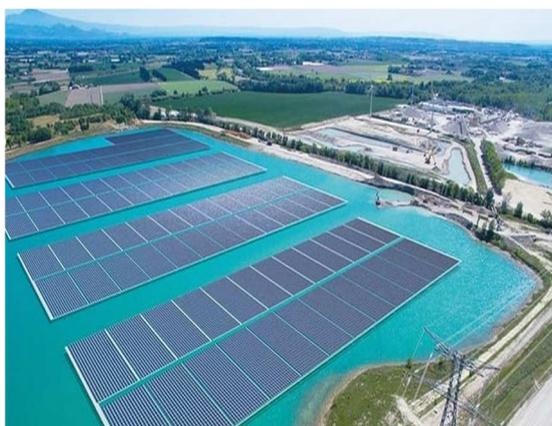
La multiplication de projets de centrales solaires flottantes représente une alternative aux centrales solaires au sol pour limiter la pression sur le foncier.
