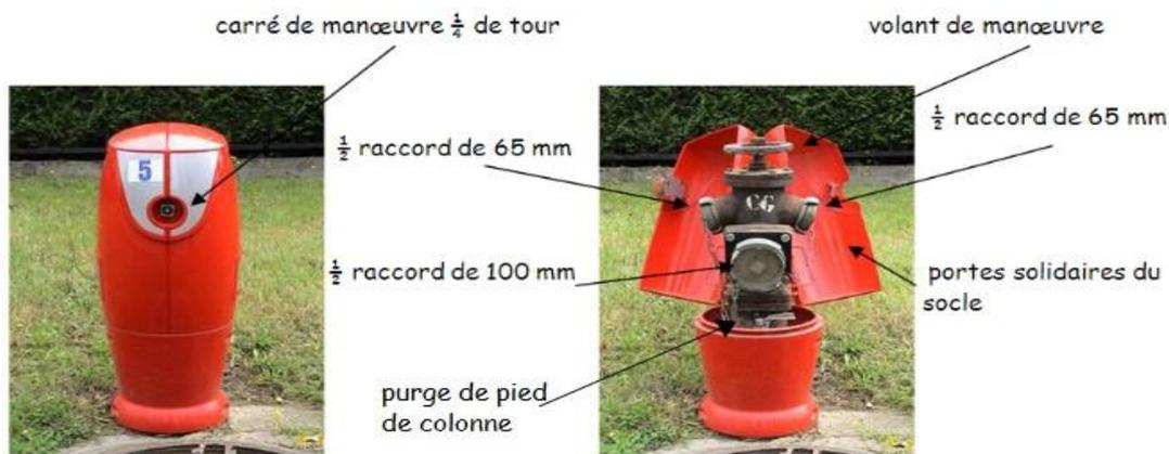
Les nouveaux P.I. sont souvent de type choc. Cela se traduit par un dispositif qui permet lors d'un accident d'éviter l'arrachement de l'ensemble du système de fermeture. En pratique cela se traduit par l'absence de jaillissement de l'eau.
