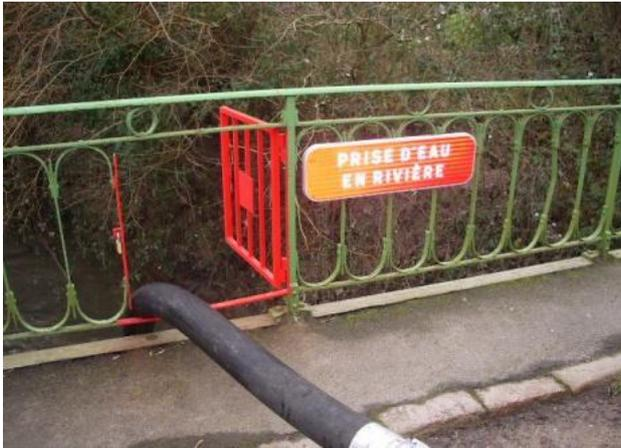
Afin d'éviter le col de cygne, il est nécessaire de créer dans les garde-corps un guichet afin de faire passer les tuyaux d'aspiration.
