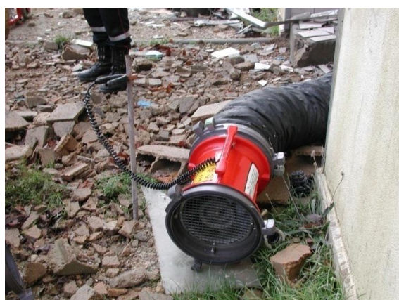
Illustration n°2 : Utilisation d'un hydro ventilateur
